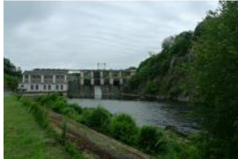
Barrage de La Roche au Moine
